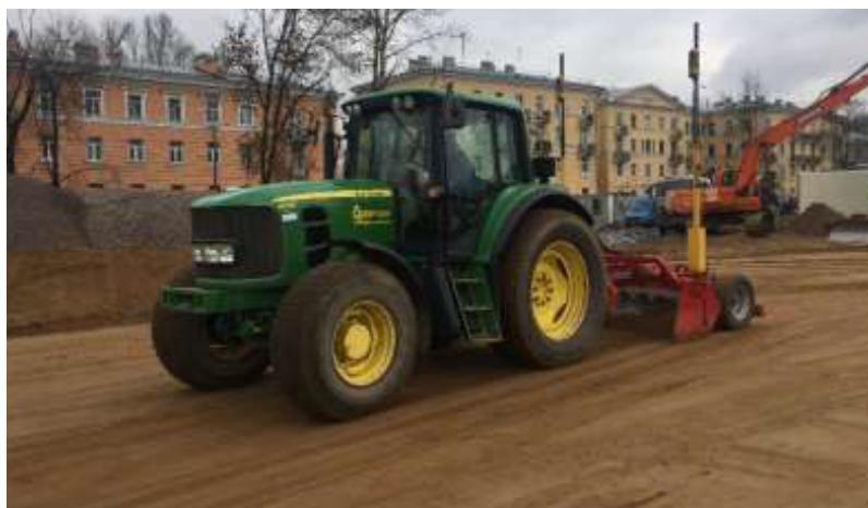
Rys. 13 Niwelacja tolerancji z wykorzystaniem lasera.
