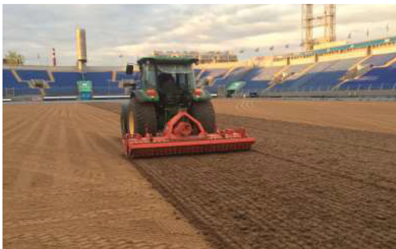
Rys. 15 Montaż wzmocnionej warstwy korzeniowej
