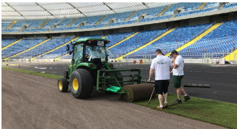
Rys. 24 Montaż murawy
