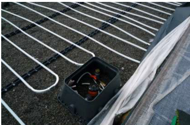
Rys. 9 Montaż modułu sterowania systemem nawadniającym
