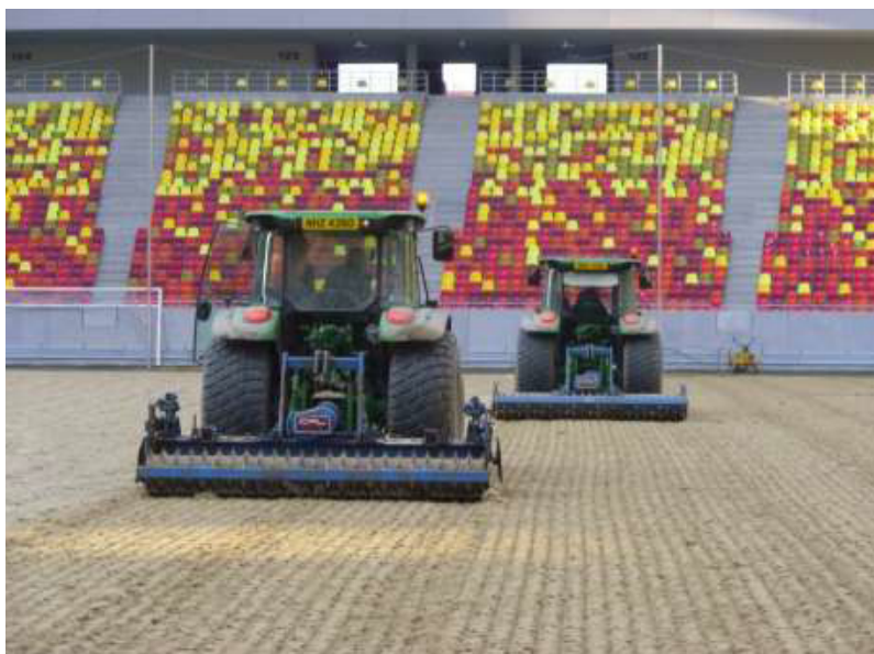
Rys. 51 Przekształcenie murawy w murawę tkaną z włókien.
