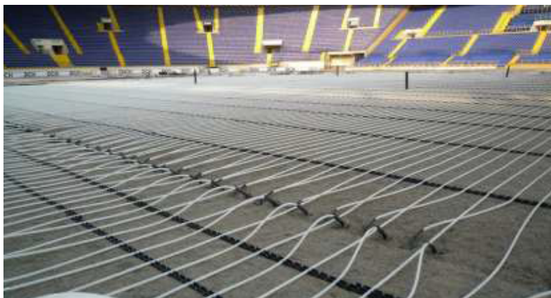
Rys. 10 Montaż podziemnego systemu grzewczego.
