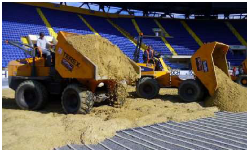
Rys. 2 Użycie właściwego piasku ma kluczowe znaczenie w przygotowywaniu każdej nowej murawy.
