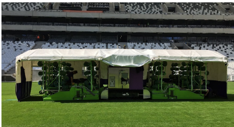
Rys. 17 Montaż zszywanej trawy hybrydowej
