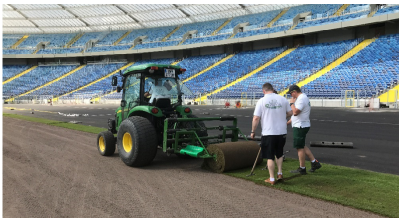
Rys. 24 Montaż murawy
